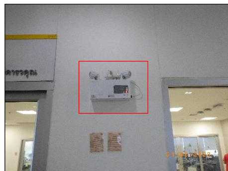
รูปที่ 2-56 เครื่องกำเนิดไฟฟ้าสำรอง และระบบไฟแสงสว่างฉุกเฉินแบบใช้แบตเตอรี่ (2)
