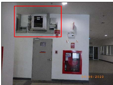
รูปที่ 2-55 เครื่องกำเนิดไฟฟ้าสำรอง และระบบไฟแสงสว่างฉุกเฉินแบบใช้แบตเตอรี่ (1)
