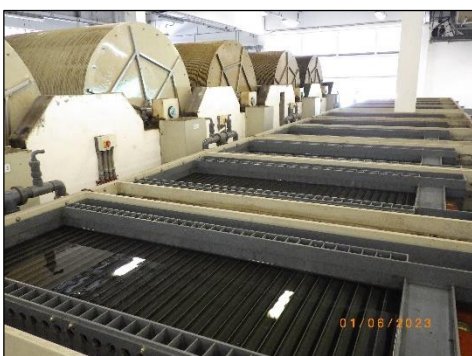
รูปที่ 2-7 ระบบบำบัดน้ำเสียรวม แบบ RBC
